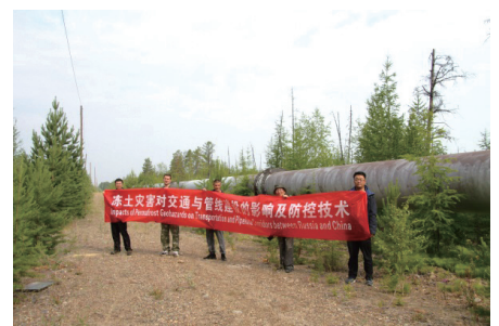
图3 管道沿线冻土灾害联合考察
